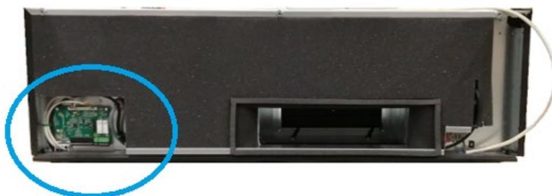
Figur 9: AMX 4 med sideplaten fjernet
