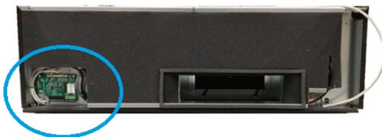
Figur 9: AMX 4 med sideplaten fjernet
